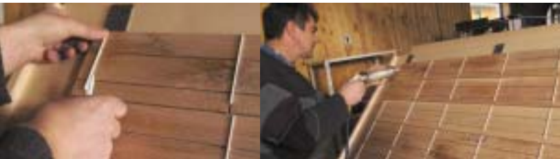
>> Montage der Stabilisatoren >>
